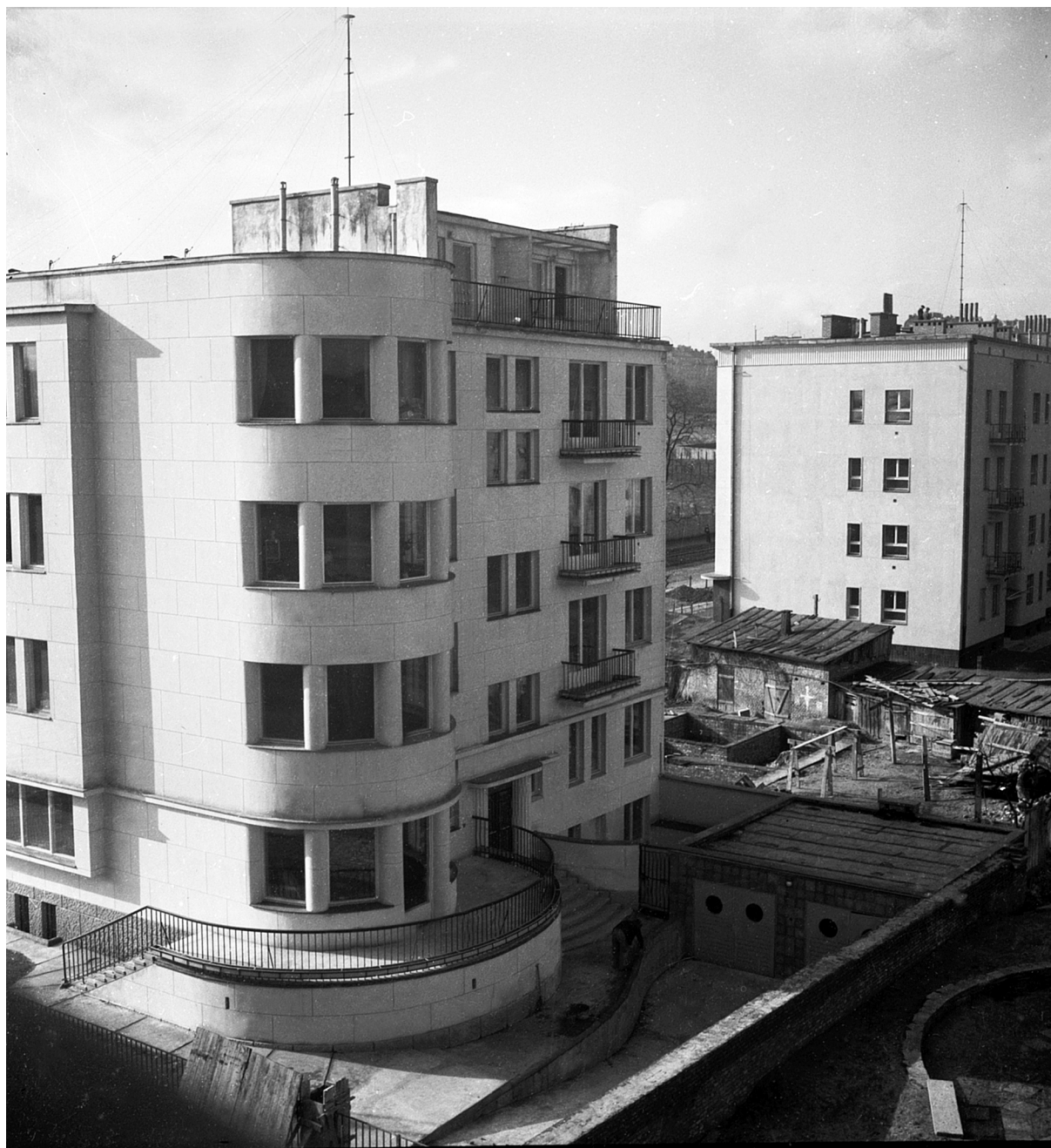
Ilustracja 14. Warszawa, ul. Belwederska 40/42 — budynek wielomieszkaniowy Bergmana. Widok od strony obecnej ul. Łądowej. Widoczne podwórze z garażami, a w głębi plac budowy nowej części budynku na parceli przy ul. Belwederskiej 42. Stan w marcu 1939 roku. Proj.: ul. Belwederska 40 — Remigiusz Ostoja-Chodkowski (1937); ul. Belwederska 42 — Henryk Douglas (1938). Fot. Szymon Syrkus [?]. Zbiory Naukowe ZAP WAPW, Fototeka, b.s.
